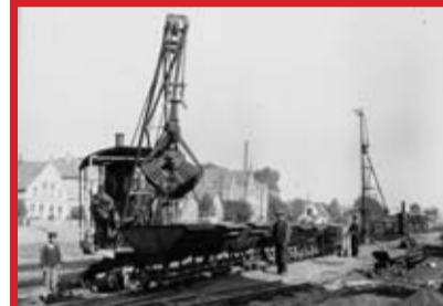
Bau des Küstenkanals, Uferstraße, 1920er Jahre - Foto Gustav Alexander Tahl
